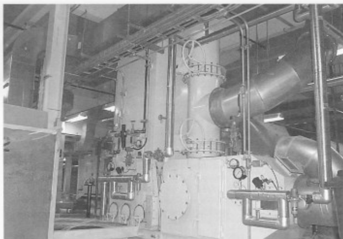
3: Kompakt-Aerosolabscheideanlage für einen Volumenstrom von 11000 m³/h
